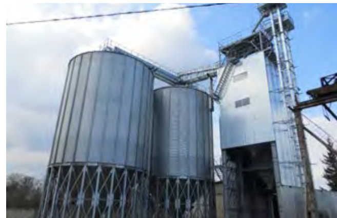
Grain elevator «Bychachagrohlebprom» S.R.L. (Ukraine)
